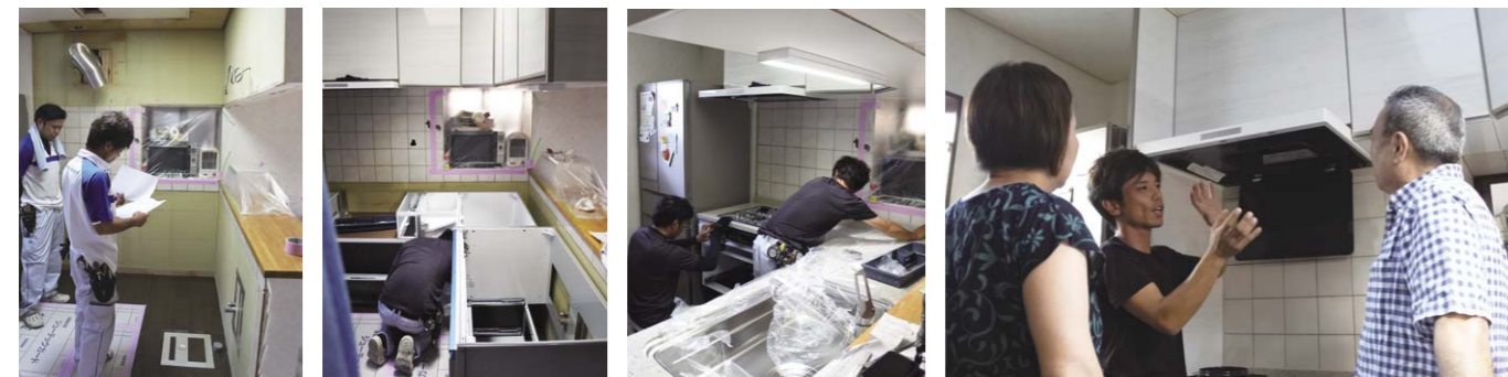
エンジニアが現場に合わせて微調整を行いながら、びったり納めていく。
